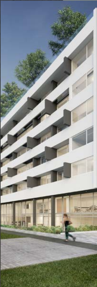
EDIFICIO ALBORA Santiago Centro
